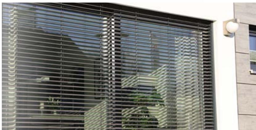
Pris en compte dans la catégorie des stores orientables (apports solaires et luminosité), le BSO est bien valorisé dans les calculs RE 2020 pour sa capacité à limiter la surchauffe en été tout en conservant la luminosité intérieure.
